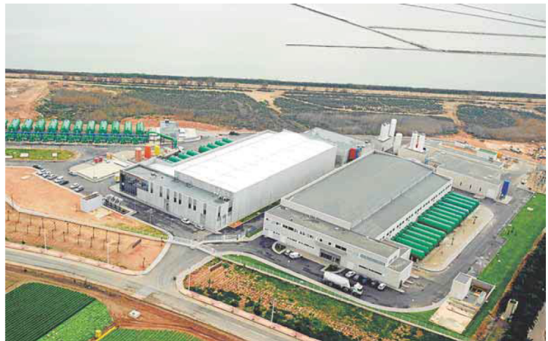
Planta desaladora de San Pedro del Pinatar, gestionada por la Mancomunidad de Canales del Taibilla. LV
